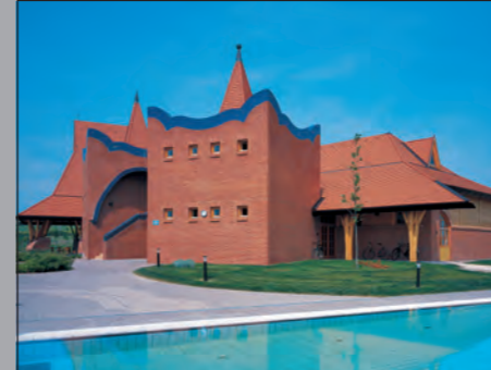
Ortgangausbildung der Doppeldeckung mit „KERA-BIBER“ Schiebe-Ortgang ½.
